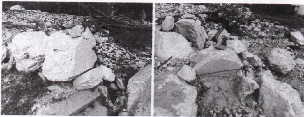
Slika 96 i 97. Primjeri obrađenih blokova u zoni porušenih objekata
