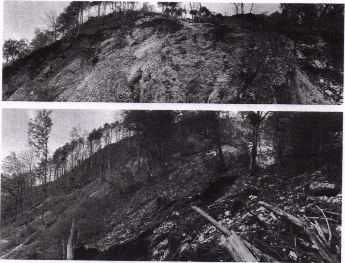
Slika 81. Mjesto iniciranja primarnog debritnog toka u koluvijalnom materijalu, 770 m.n.v.
